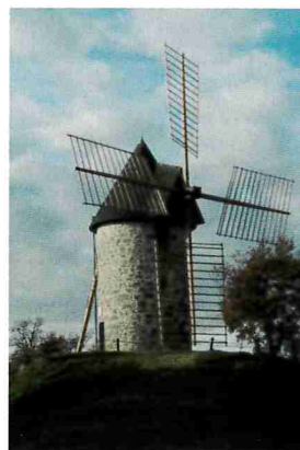
Moulin de Coulx (ailes réparées)
