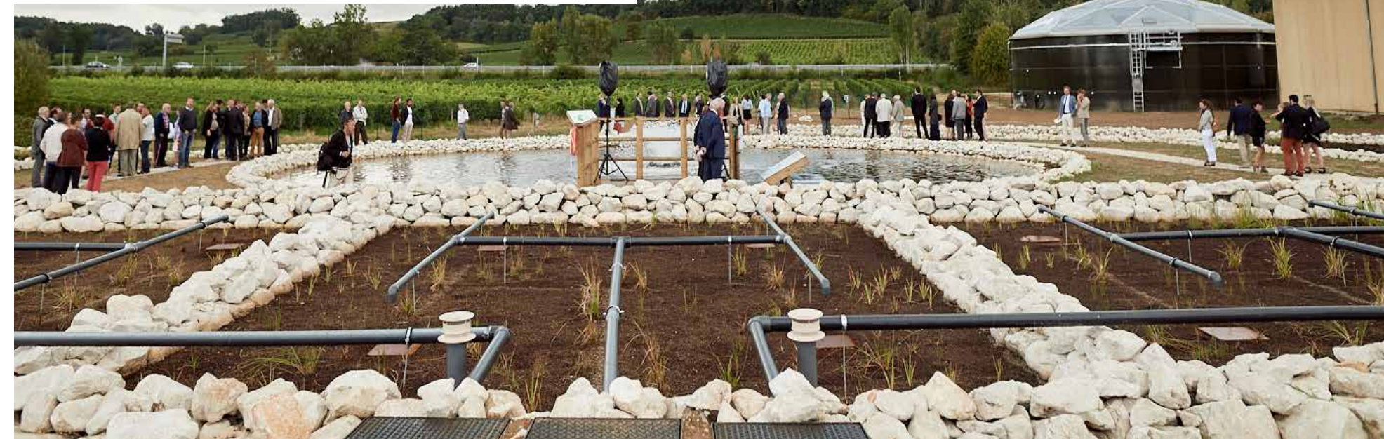
Le Jardin des filtres a été intégré au circuit de visite de la coopérative Les Vignerons de Buzet, avec un parcours pédagogique accessible à tous les publics, y compris les scolaires !
