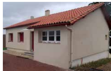
Après les travaux d'isolation et de menuiserie.
