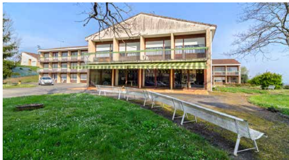
L'Ehpad du Mas-d'Agenais est en cours de rénovation.
